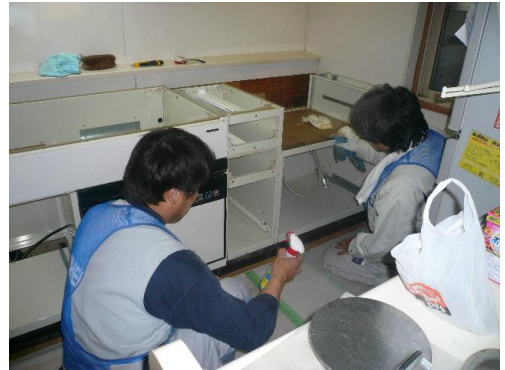
システムキッチンの取り付け作業
