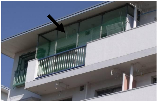
土鳩対策としてベランダに網が張られた。
