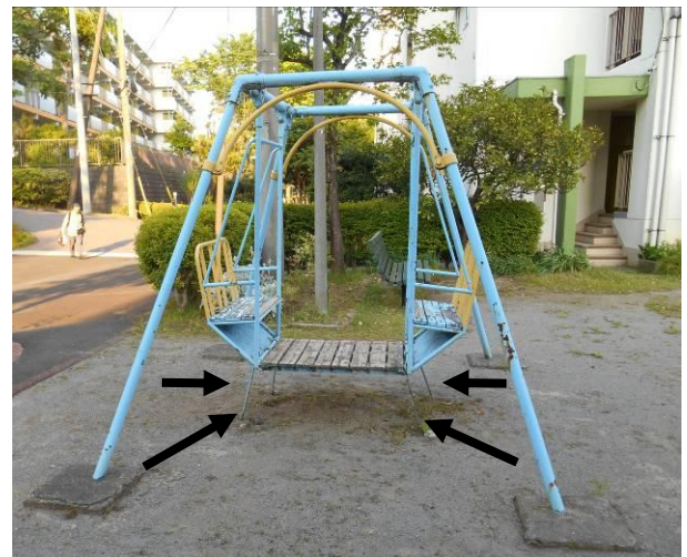
鉄棒で固定(矢印 4 箇所)され動かなくなった箱型ブランコ = 厚木市の鳶尾第二住宅で
